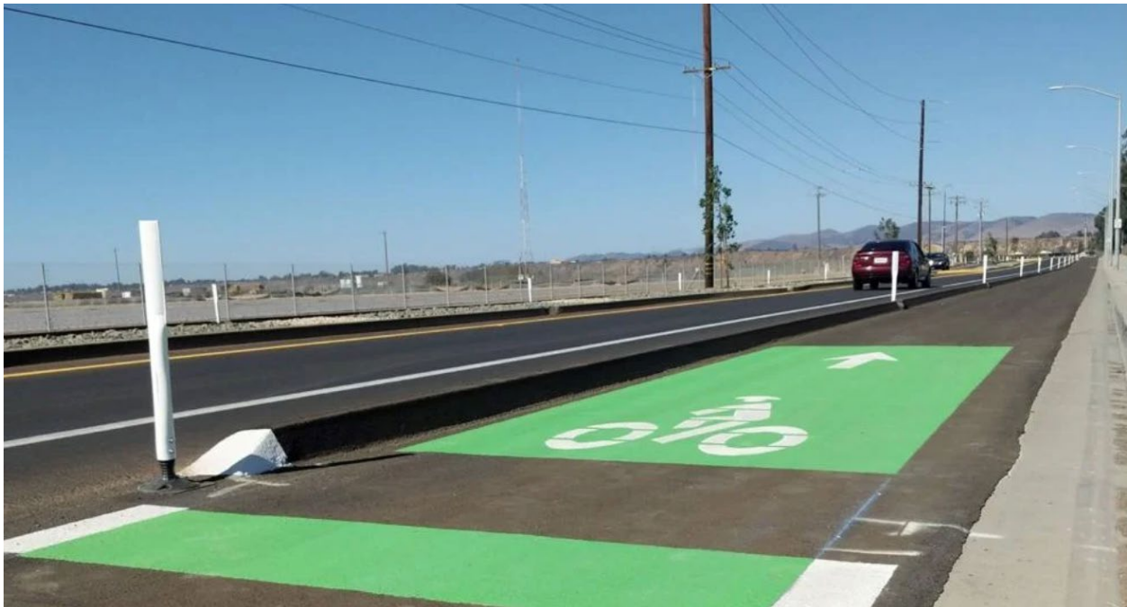
Carril bici protegido instalado en Blosser Road en 2023.
