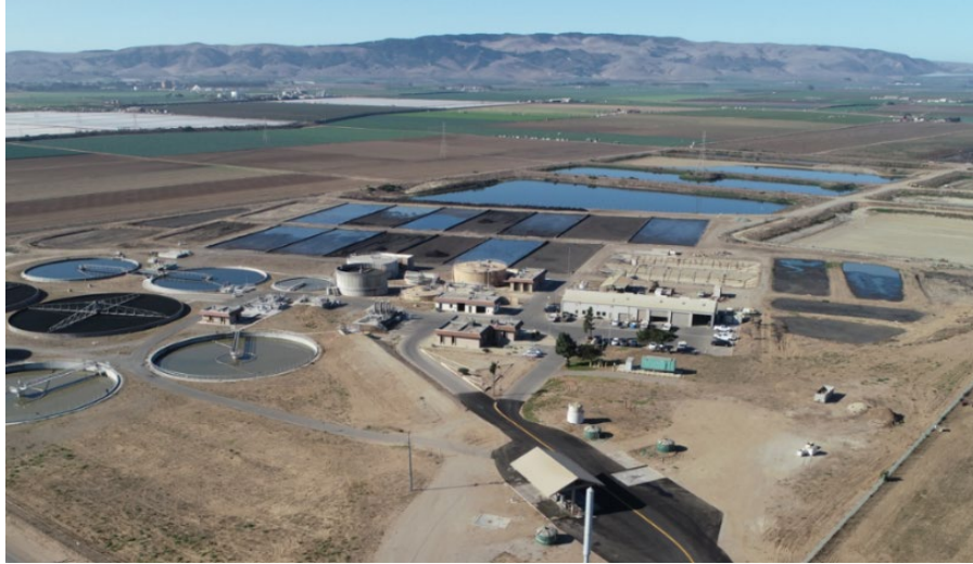
Planta de tratamiento de aguas residuales de la ciudad de Santa María.
