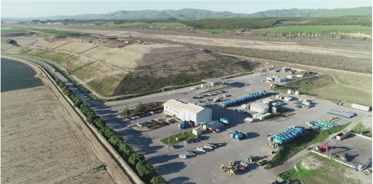
Santa Maria Landfill
