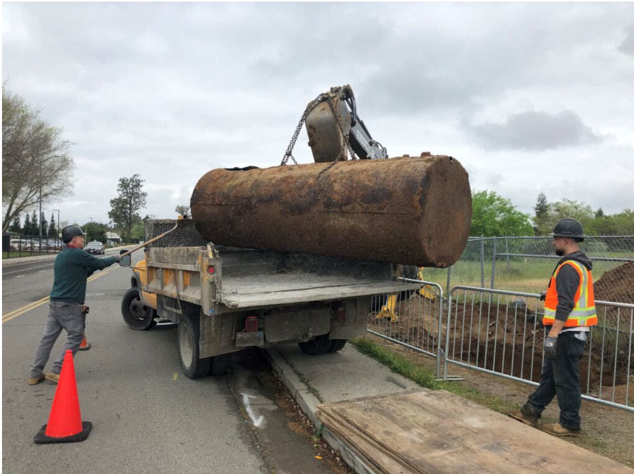
Se retira un depósito subterráneo abandonado como parte del proceso de remediación.
